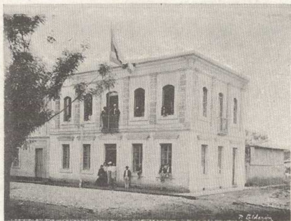
La Casa Municipal.—Villa de Desamparados
